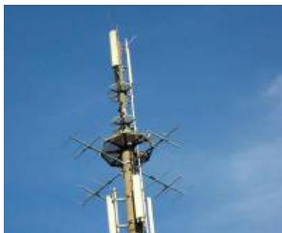
Ein **Umsetzer** ist eine Einrichtung, welche in der Lage ist, ein empfangenes Funksignal wieder auszustrahlen. Die ursprüngliche Definition meinte einen Verstärker, welcher aber nicht am Ort des Senders beheimatet ist. In der analogen Rundfunktechnik wurden Umsetzer genutzt, um die Radioprogramme auch außerhalb der Reichweite einer Sendeantenne auf dem Funkhaus verbreiten zu können.
